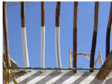
Ensayos de color realizados sobre la estructura de madera.
