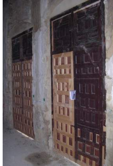
Puertas balconeras de la galería alta del Palacio.
