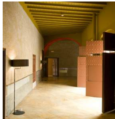
Vistas de las galerías del Palacio del siglo XVIII una vez concluidas las obras.
