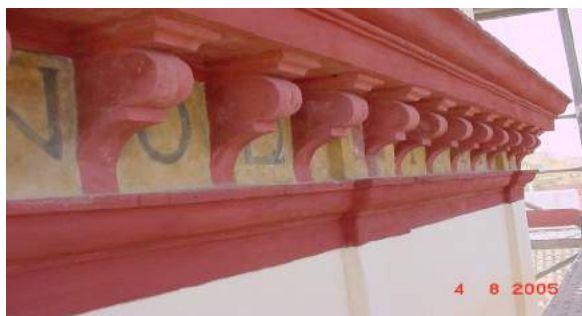
Policromía recuperada en la torre, estado inicial y final.
