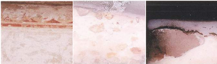
Zona de obtención de la muestra y detalle de los componentes de la capa pictórica, MUR-1.
