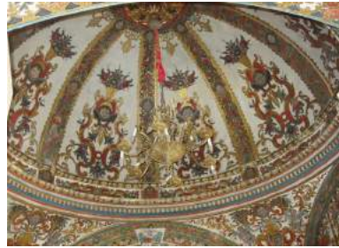
Bóveda encamonada y tabicada sobre la capilla situada en planta primera.
