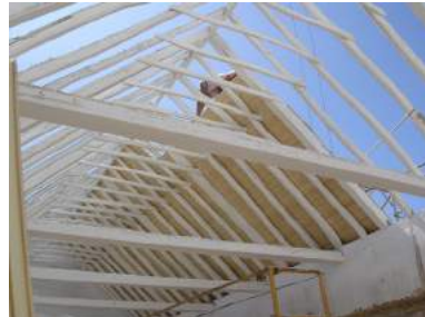
Instalación de paneles aislantes de cubierta una vez finalizado el saneado de la estructura.
