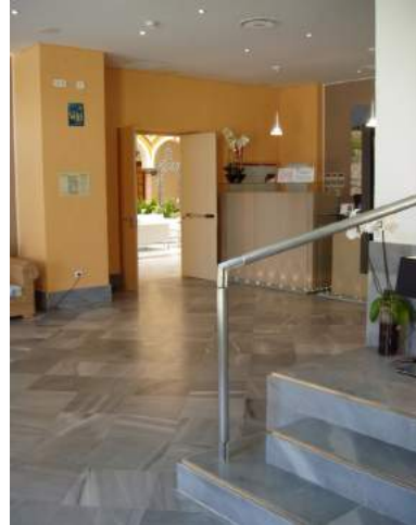
Solería de planta baja de la bodega colindante con el Palacio del siglo XVIII.
