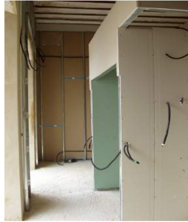
Formación de tabiquería con paneles de cartón-yeso y estructura de perfiles metálicos.
