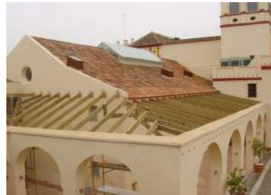
Lucernario y remates de ventilación enrasados con la cubierta.
