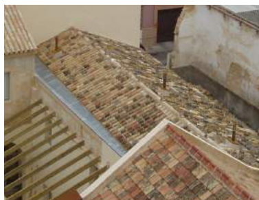
Vista de la cubierta del almacén de las Tinajas.
