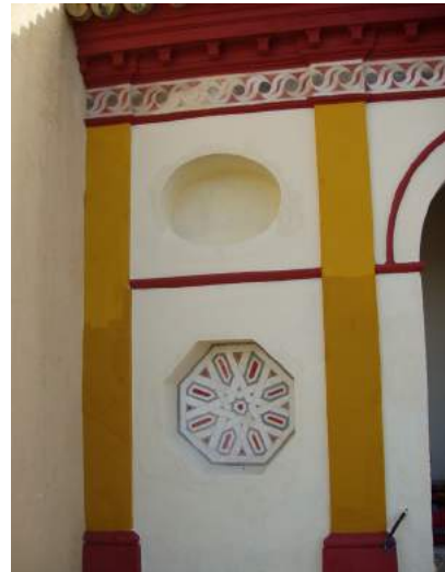
Estado inicial de la fachada Oeste del Palacio del siglo XVIII con restos de pintura mural.
