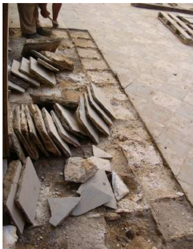
Levantado e inventario de las baldosas de mármol que conformaban el solado del patio.
