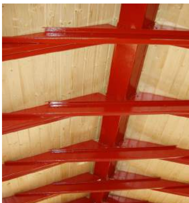
Vistas interiores de la ejecución de la nueva cubierta del almacén de las Tinajas.
