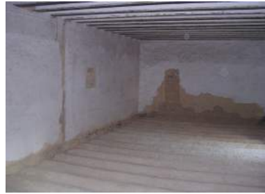
Eliminación de la capa de compresión de arena y tierra, y limpieza del extradós de los revoltones de yeso y ladrillo en los forjados originales.
