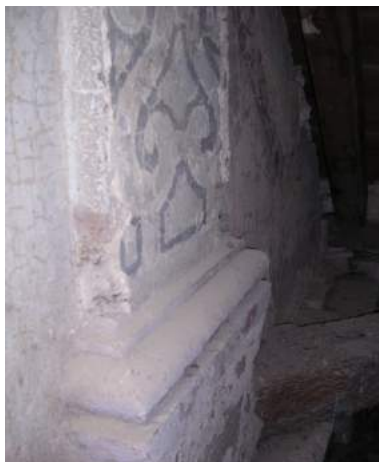
Policromías existentes en pilastras de planta segunda, ocultas entre la cubierta y el extradós de la cúpula.
