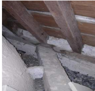
Estructura de madera en par y nudillos, que cubre el extradós de la cúpula y los cuadrales de apoyo.
