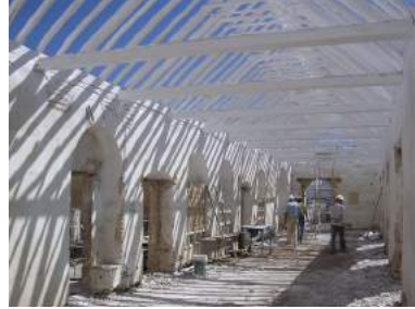
Estructura de la cubierta una vez saneada y protegida con esmalte blanco semi-mate.
