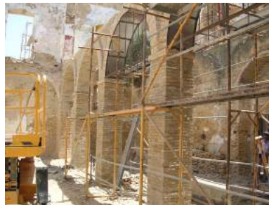
Pilares reconstruidos en el almacén del siglo XVII.
