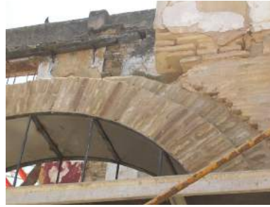
Reconstrucción de los arcos con empleo de ladrillos antiguos que estaban dispersos por el inmueble.
