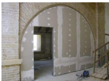
Tercer sistema. Cegado de arcos.
