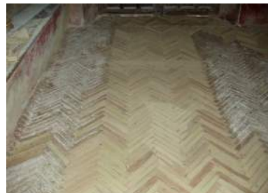
Reparación de la solería de ladrillo original, con una zona completada con ladrillo antiguo, en el zaguán del Palacio del siglo XVIII.
