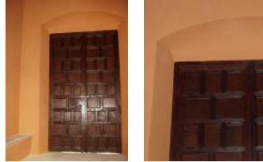
Portón principal frente a la calle de la Divina Pastora.
