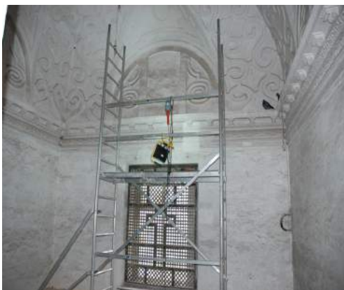
Inicio de los trabajos de limpieza del intradós de la bóveda.
