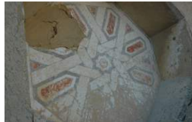
Estado inicial de los octógonos de entrepaños existentes en las fachadas.
