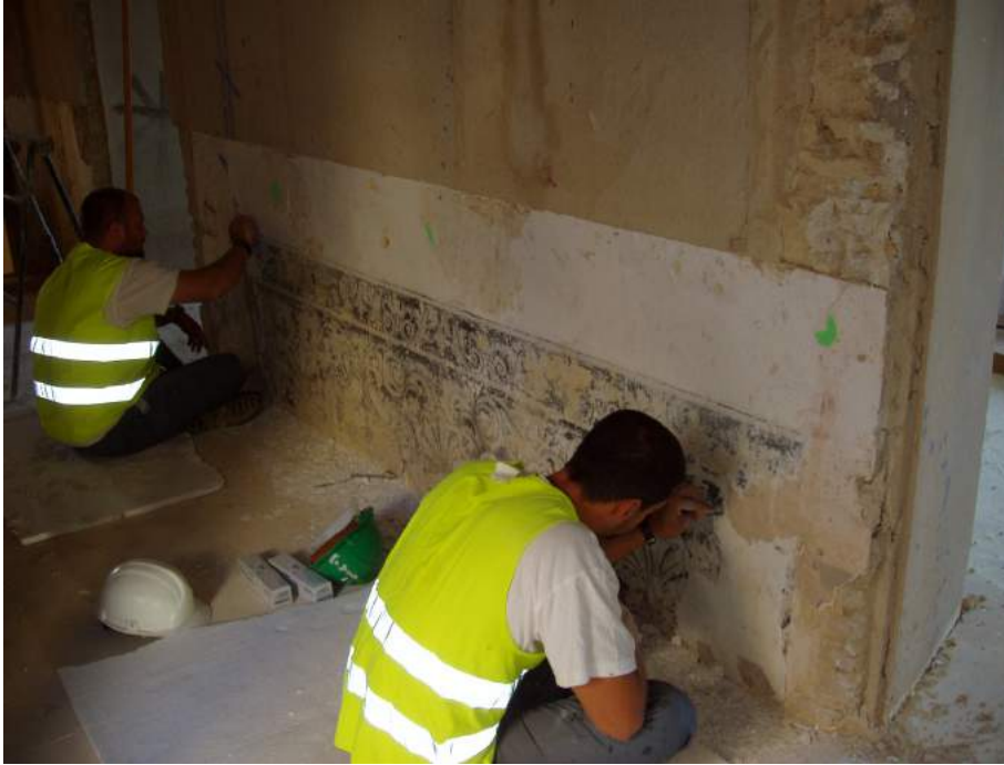
Trabajos de limpieza y conservación de los zócalos.
