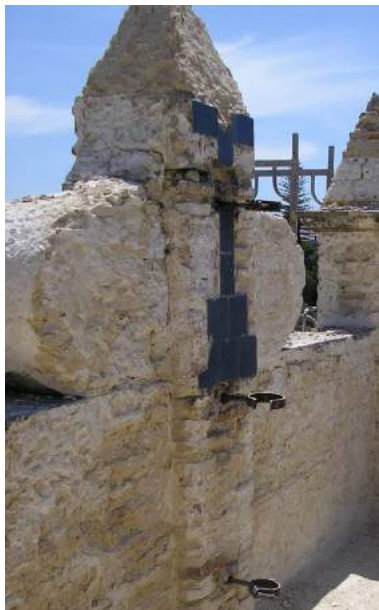
Pilastra con abrazaderas, donde se colocaban las banderas de señales para comunicarse con los navíos.
