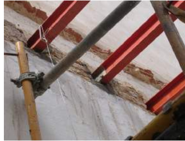
Colocación de nuevas viguetas metálicas IPE 100 en los mechinales originales.
