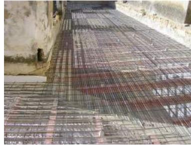
Colocación sobre malla de «nervometal» del mallazo 15.15.6 con separadores.
