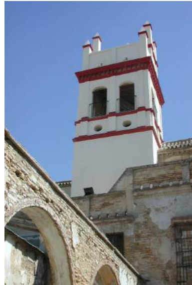
Vista de la torre al finalizar los trabajos de rehabilitación.
