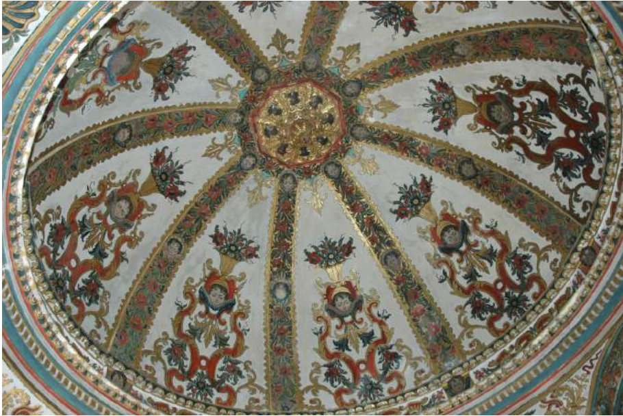
Cúpula de la capilla una vez terminados los trabajos de conservación de la pintura mural.
