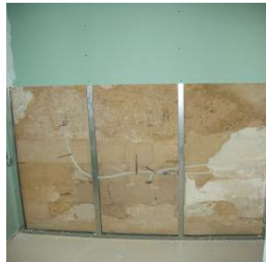
Trasdosado en muros existentes para el alojamiento de instalaciones.
