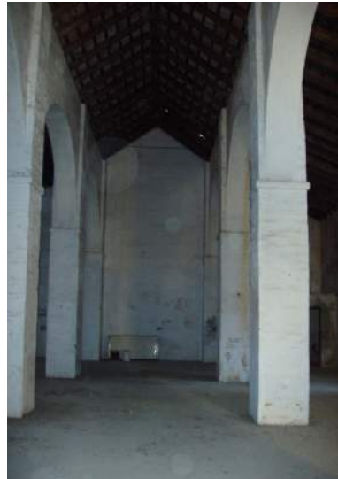
Vista del último almacén que se construyó en el conjunto arquitectónico del Marqués de Casa Arizón.
