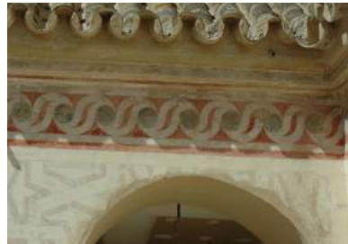
Policromía restaurada, con completamiento de lagunas con la técnica de «tinta plana».
