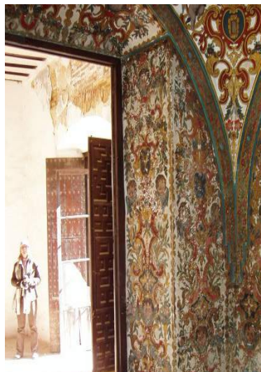
Estado inicial de los paramentos verticales de la capilla.
