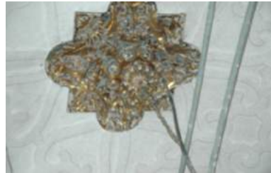
Pinjante restaurado y preparado para recibir luminarias.
