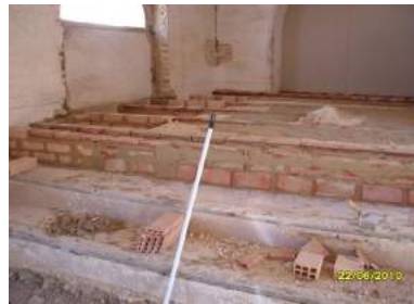
Trabajos de verificación del estado de la bóveda por el extradós y posterior protección.
