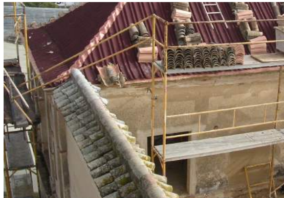
Recolocación de tejas originales como «cobija» y nuevas tejas como «canal» sobre paneles nervados.
