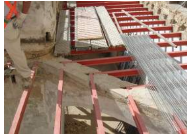
Colocación de la malla de «nervometal» sobre viguetas IPE 100.
