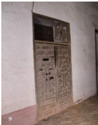
Estado de conservación de la carpintería y cerrajería original.
