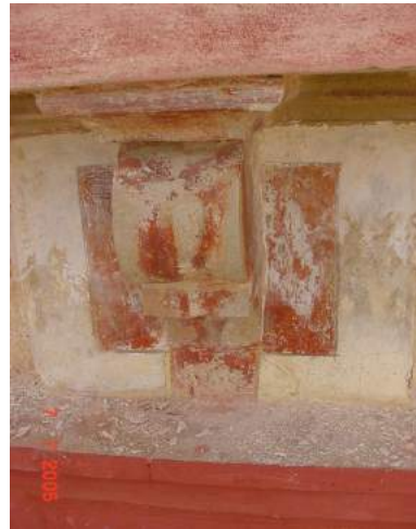
Catas de superficie para determinar la existencia de policromías en la cornisa de la torre.
