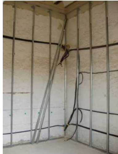
Trasdosado de muros originales con estructura de perfiles metálicos y paneles de cartón-yeso.
