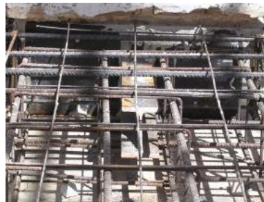
Proceso de montaje del nuevo forjado de hormigón armado.
