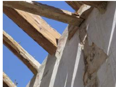
Trabajos de limpieza y reposición de la estructura de madera.
