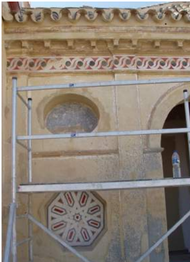
Limpieza y restitución del color en la cenefa bajo cornisa y en el interior de los octógonos, en la fachada Oeste.
