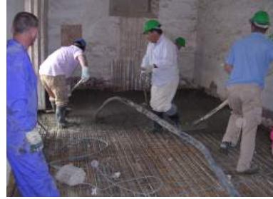
Vertido del hormigón para conformación de una losa colaborante.
