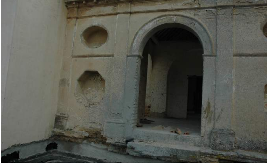
Estado final de la fachada Oeste una vez terminados los trabajos de restauración de la pintura mural.
