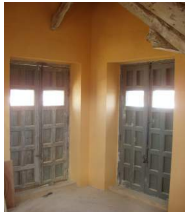
Interior de la torre, con carpinterías recuperadas.
