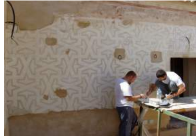
Restitución del color y completamiento de lagunas, una vez consolidado el soporte.
