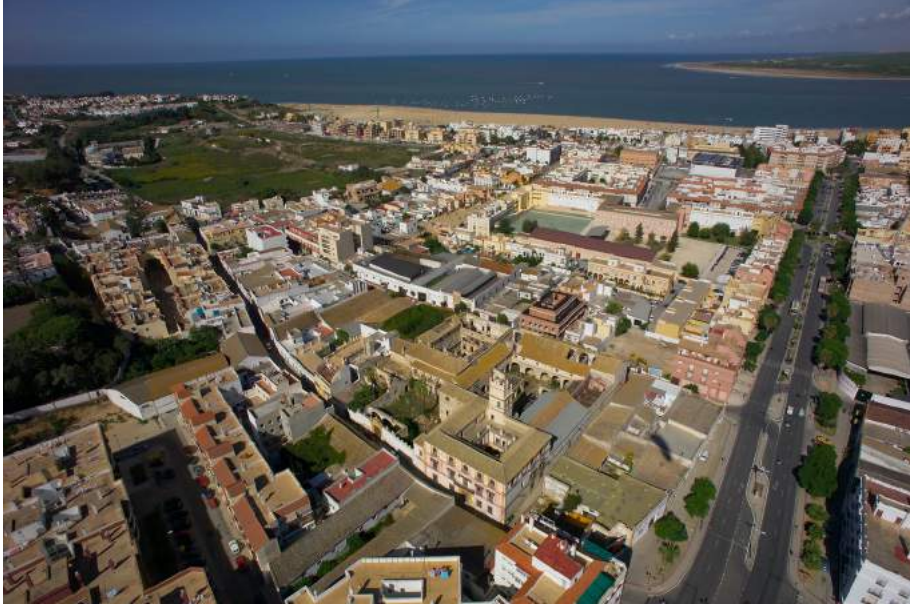
Vista aérea del conjunto arquitectónico del Marqués de Casa Arizón con la torre ya rehabilitada y previa a iniciarse el resto de las labores de rehabilitación.
