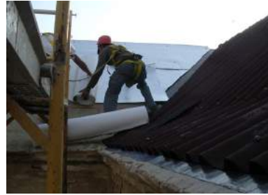
Colocación de láminas de aislamiento reflectivo en las cubiertas.
