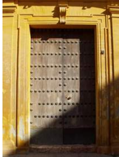
Portada de acceso en calle Divina Pastora.
