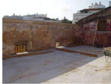
La nueva losa de hormigón armado apoyada en los muros perimetrales.
