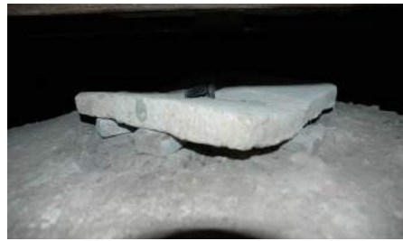
Perno recolado una vez fijado nuevamente el pinjante a la cúpula.
