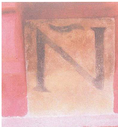
Policromías de letras en la cornisa de la torre, estado inicial y final.
