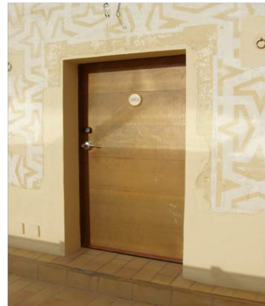
Puertas exteriores recubiertas con láminas de cobre.
