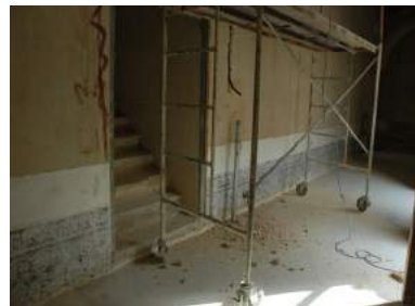
Zócalos con policromías recuperadas que estaban ocultas bajo capas de pinturas.
