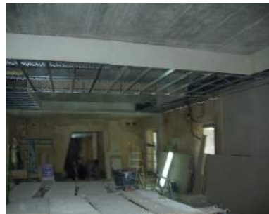
Montaje de los conductos de climatización en la zona de bodega.
