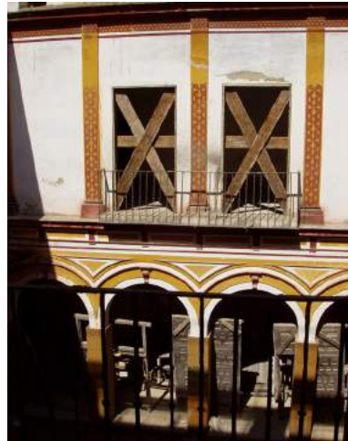
Trabajos de apeos de huecos y protección de columnas.
