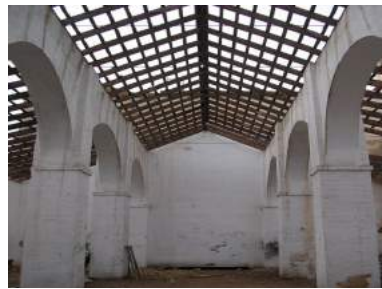
Estado inicial de la cubierta en la bodega colindante con el Palacio del siglo XVIII.
