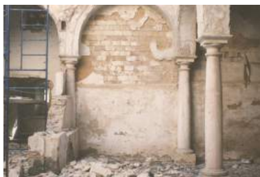
Subdivisión espacial a la que había sido expuesto el patio de la casa del siglo XVII durante su ocupación cuartelaria.
